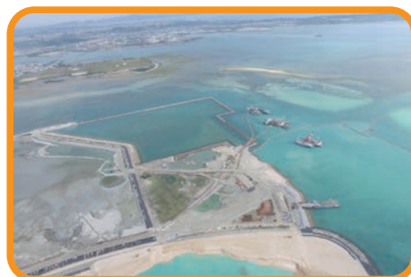
なかくすくわんこうかんれんじぎょう おきなわけん 中城湾港関連事業(沖縄県)
